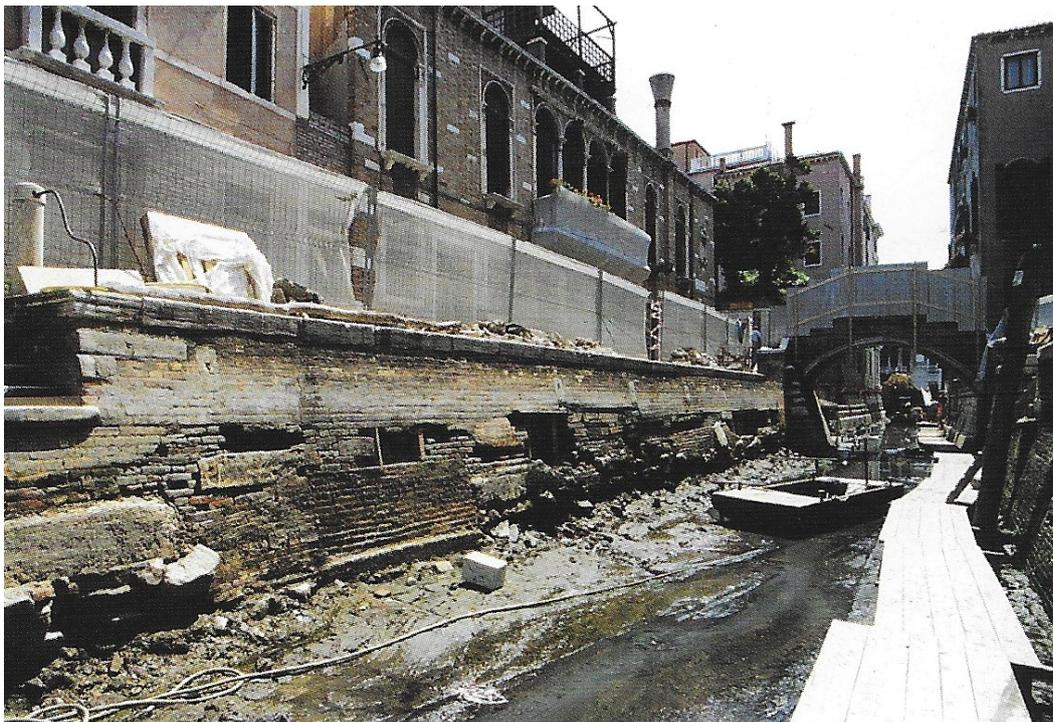
Figure 45 : Réparation en cours après assèchement d'un canal. (Fletcher, p.49)
