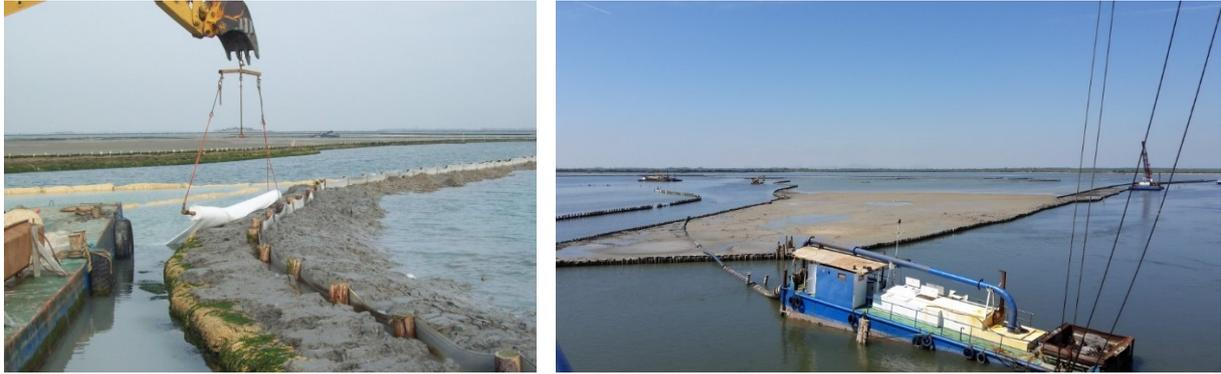
Figure 38 : Restaurations morphologiques de marais salants. A droite : réutilisation de sédiments dragués. (scuttari.it)
