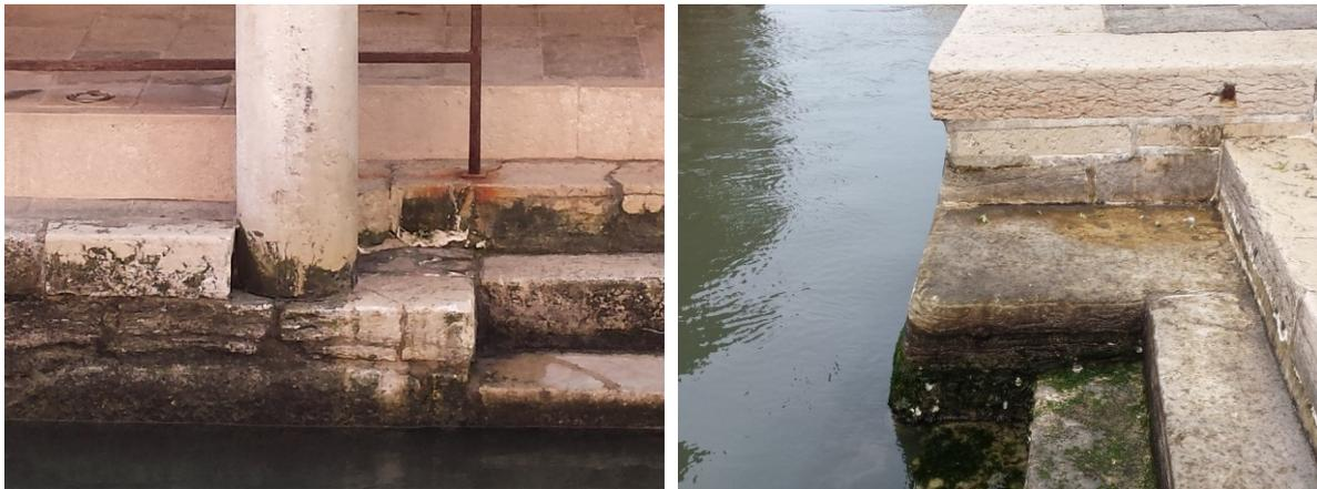
Figure 42 : Deux élévations successives du niveau du pavement. A gauche, la base de la colonne est bordée d'une première couche de pavés assez anciens tandis qu'en arrière-plan un autre niveau de pavement a été ajouté plus récemment. A droite, le bord de quai a été rehaussé plusieurs fois. (de Thier)
