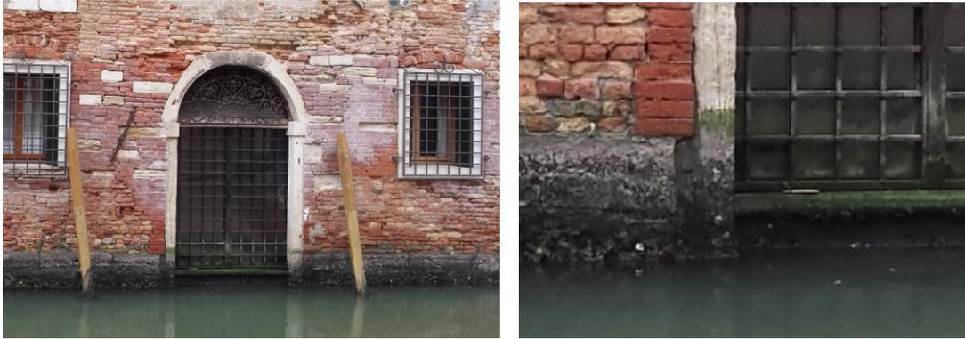
Figure 41 : Dégradations dues aux effets de l'eau et du ressac. (de Thier)
